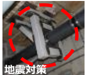
配管類サポート工事
