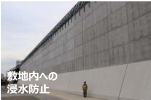
敷地内への浸水防止 防波壁 <高さ：海拔22m>
