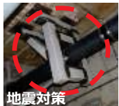
配管類サポート工事
