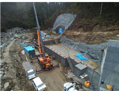
清内路水力発電所 (建設状況)
