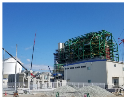
米子バイオマス発電所 (建設状況)
