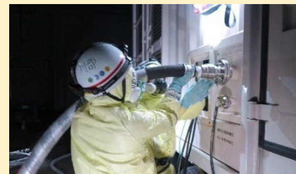
タイバックスーツを着用した夜間訓練 （窒素供給車両への電源接続）
