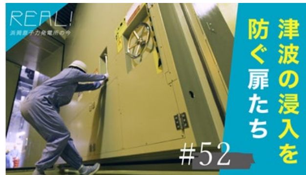
原子炉建屋への浸水を防ぐ対策
