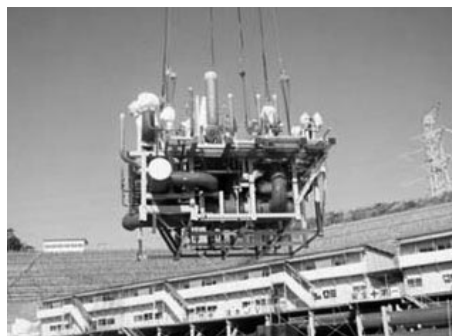
モジュールブロックの搬入状況
