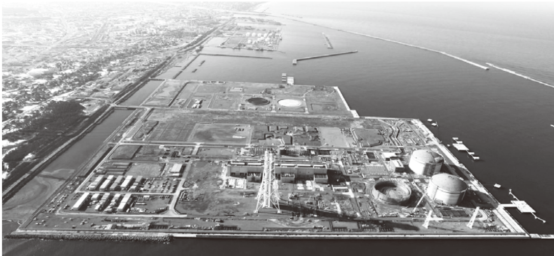
上越火力発電所建設状況(平成21年12月時点)
