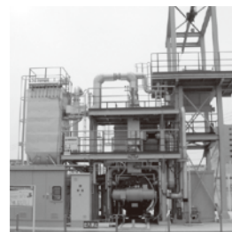
あいち臨空新エネルギーパーク（愛知県常滑市）で木質バイオマス利用スターリングエンジン発電システムの研究開発を行っています。
