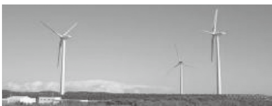
御前崎風力発電所(第1期)
