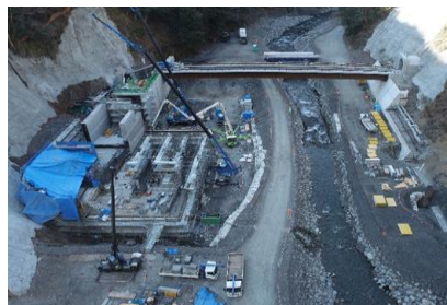
安倍川水力発電所 (えん堤工事状況)
