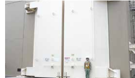
③ 電源供給の代替手段の確保 緊急時ガスタービン発電機の設置
