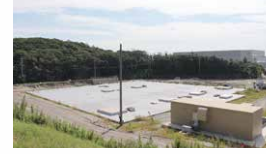
④ 注水の代替手段の確保 緊急時淡水貯槽の設置
