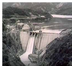
井川水力発電所(1957年)
