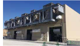
③ 電源供給の代替手段の確保 緊急時ガスタービン発電機の設置
