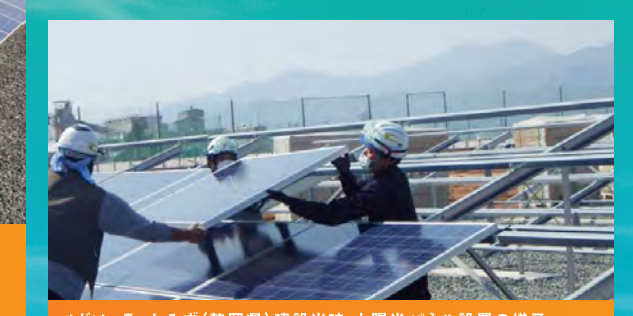
メガソーラーしみず(静岡県)建設当時 太陽光パネル設置の様子
