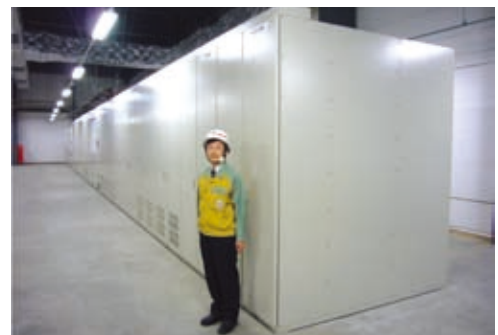
高圧大容量電気二重層キャパシタ式瞬低補償装置 (10,000kVA、1秒補償)
