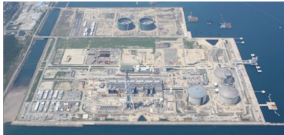
上越火力発電所建設状況(2011年6月時点)
