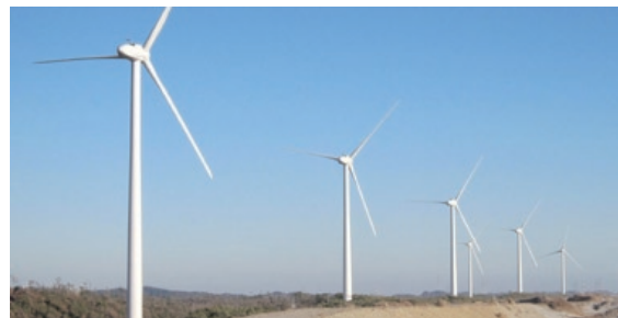
御前崎風力発電所
