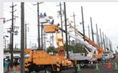
全電力会社10社による配電設備復旧訓練の様子(愛知県日進市)
