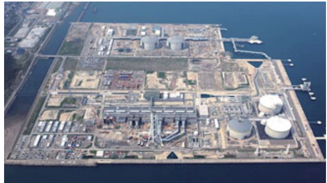
2012年7月に1-1号機の営業運転を開始した上越火力発電所
