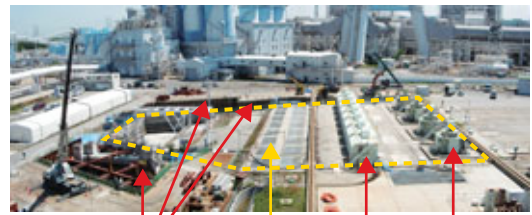
(写真左が海側) クリーナー 取水ポンプ 地盤地下をコンクリートなどで補強・強化している箇所 この黄点線枠内の地下に取水槽があります
