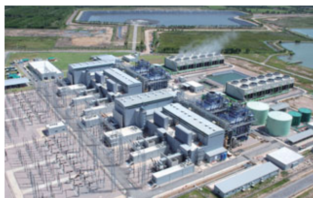
ガス火力発電事業へ出資するとともに、発電所の運転・保守や技術支援を実施しています。(タイ ラチャプリ ガス火力発電事業)
