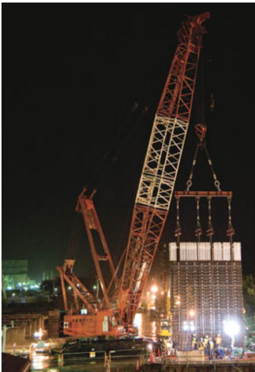
基礎部の鉄筋設置
