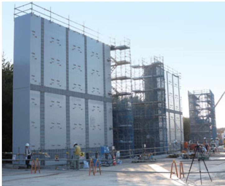
たて壁の設置
