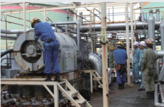
再稼働に向けて機器の整備をおこなう(株)中部プラントサービスの従業員
