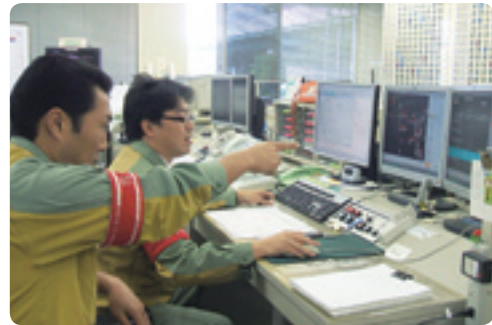
配電線自動化システムによる遠隔操作
