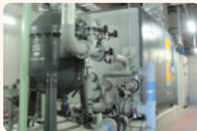
世界最大級出力のスクリーンインバーターコンプレッサーと吸着式ドライヤー
