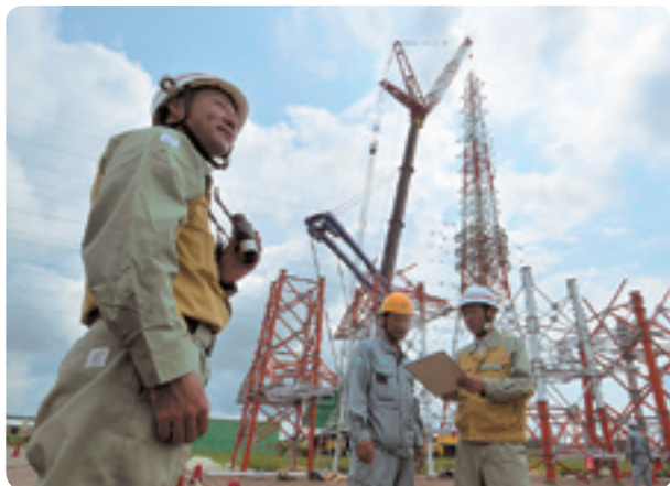
需要の増加に対応した送電線建設工事
