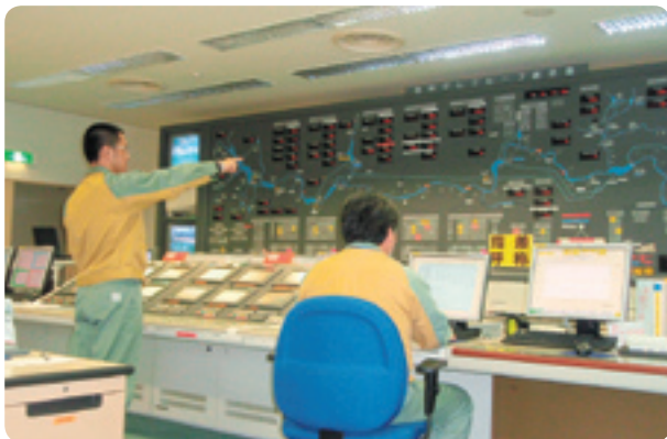
秋神ダム管理所のダム監視状況
