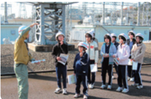
東部変電所(愛知県豊田市)設備の見学会
