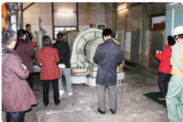
阿保水力発電所を視察
