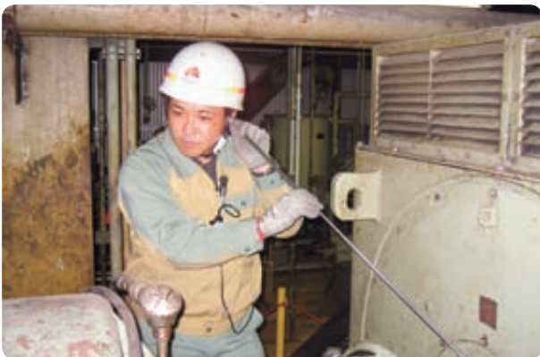
火力発電所で給水ポンプの駆動用モータの音を確認する作業
