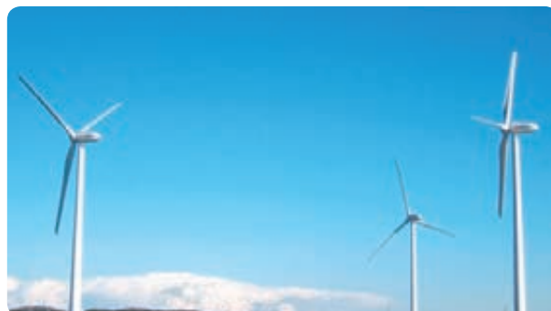
御前崎風力発電所(第1期)
