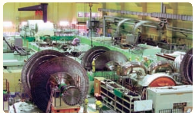
低圧タービン取替作業を行う5号機
