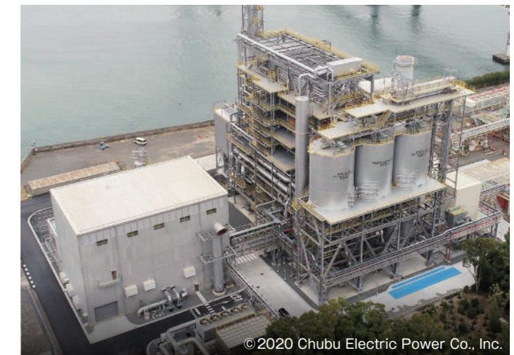
▲四日市バイオマス発電所 建設全景
