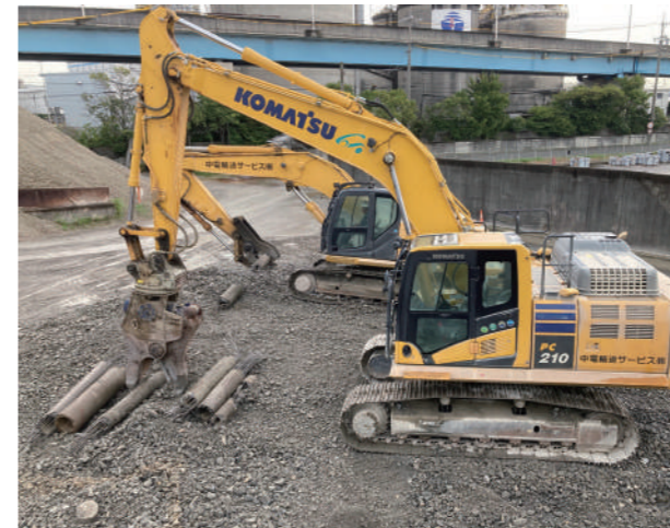
▲使用済みコンクリート電柱の破碎現場 (中電輸送サービス(株) 破碎処理:愛知県)
