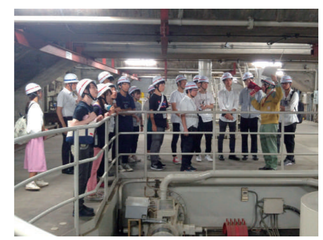
▲環境エネルギー塾 水力発電所を見学している様子。
