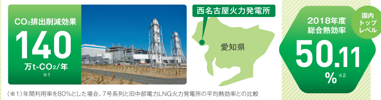
図1 西名古屋火力発電所について
