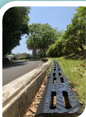
側溝用の蓋の設置
