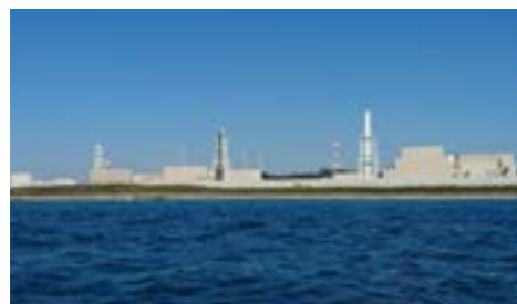
浜岡原子力発電所
