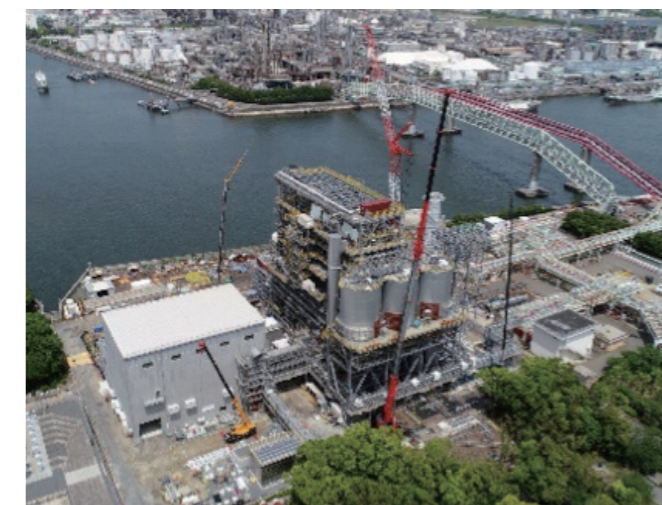
▲四日市バイオマス発電所 建設全景
