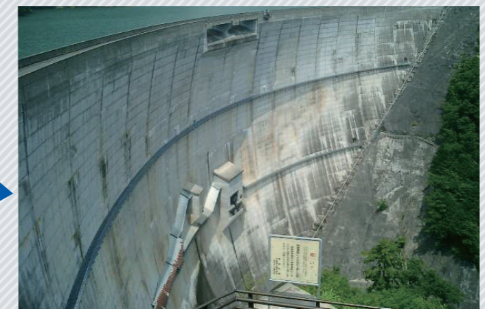
▲フライアッシュセメントを使用した奥美濃水力発電所の川浦ダム
