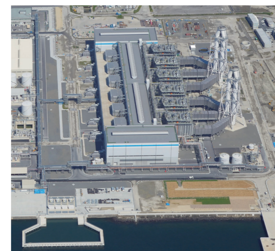
▲世界最高水準の熱効率を誇る西名古屋火力発電所
