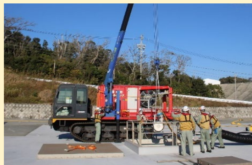
可搬型注水設備設置訓練
