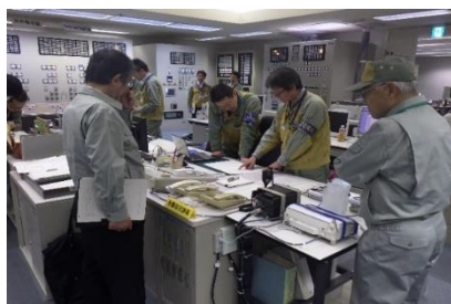
委員による現場確認
