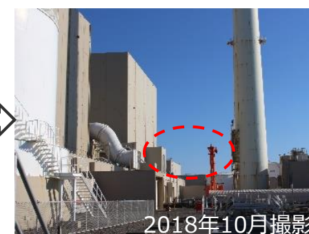
排気筒接続部の排気ダクト解体撤去の状況
