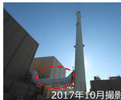
排気筒接続部の排気ダクト解体撤去の状況
