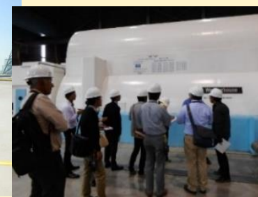
DCPPの現場観察
