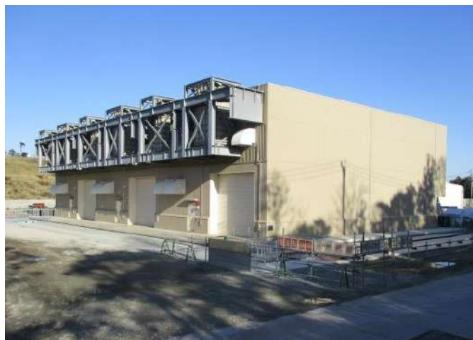
緊急時ガスタービン発電機建屋
