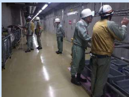
委員による現場確認
