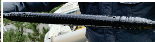
写真3 当該連系線の補修状況
