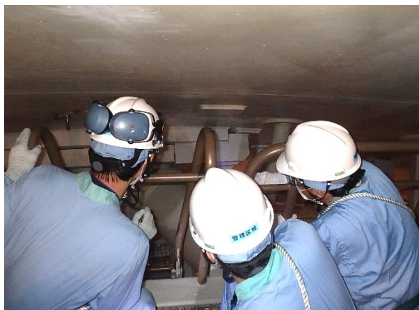
原子炉格納容器シヤラグ 補強工事点検の様子
