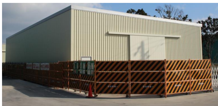
クリアランス搬出待ち倉庫(第1棟)
