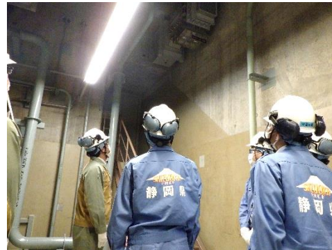
浸水防止ダンパの据付状況を 確認いただいている様子
