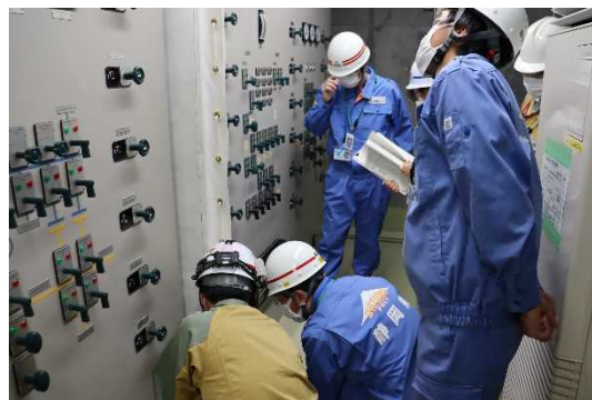
耐火隔壁の点検の様子
