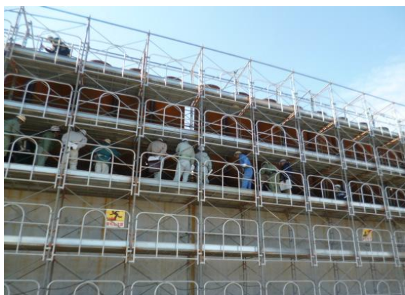
西側端部嵩上げ部点検の様子
