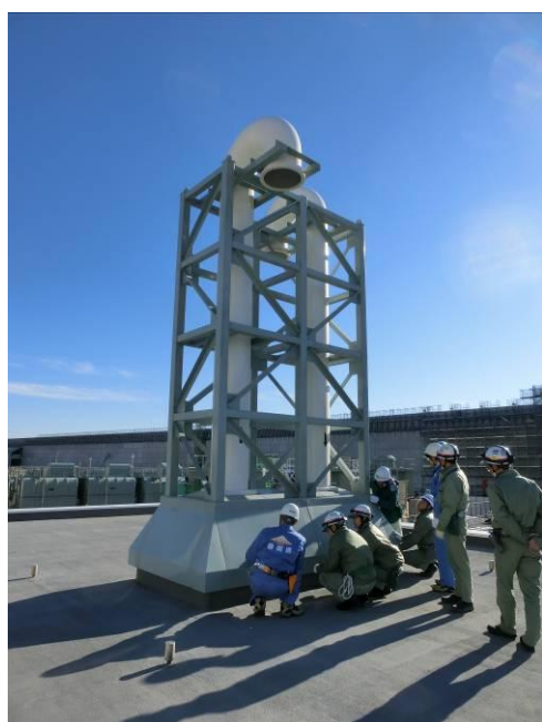
3号機建屋外壁の給排気口(開口部)からの浸水防止対策 点検の様子
