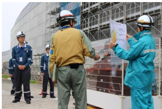
現地調査の様子(防波壁)
