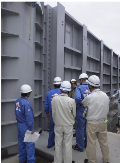
取水槽他の溢水対策工事 点検の様子
