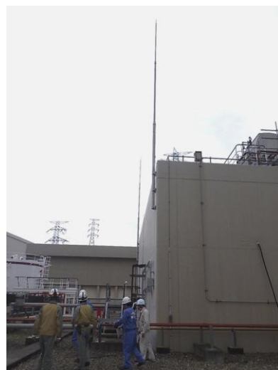
避雷設備の設置工事 点検の様子
