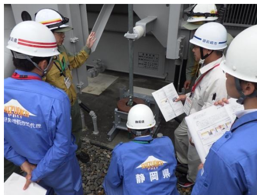
変圧器一相開放対策 点検の様子
