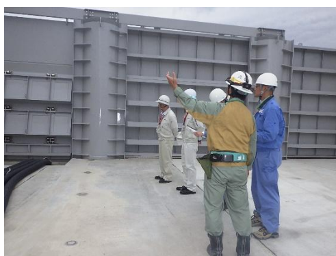
取水槽他の溢水対策 点検の様子
