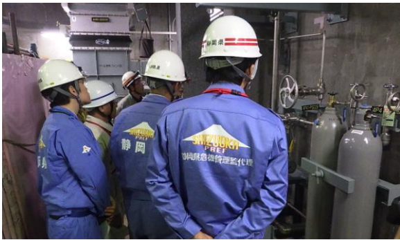
取水槽レベル計測設備の耐震性向上 点検の様子
