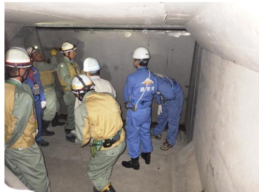
取水槽他の溢水対策 点検の様子
