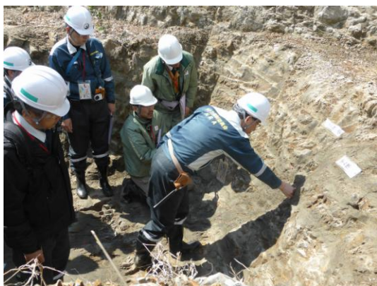
現地調査の様子 (浜岡原子力発電所 敷地内)
