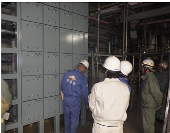
原子炉建屋における換気空調系開口部の竜巻対策
