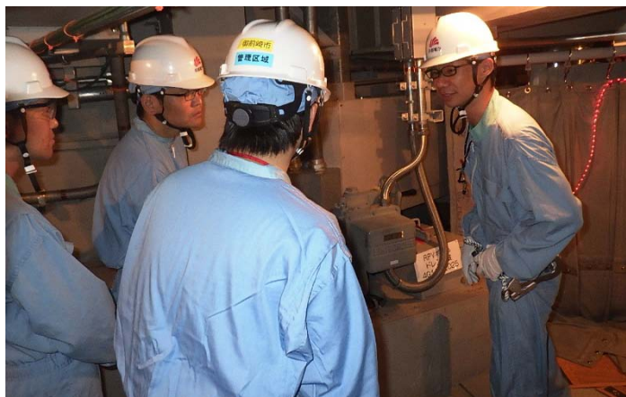
原子炉圧力容器ボトムドレン弁電動化工事 点検の様子
