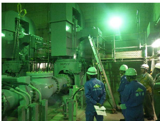
電源盤などの上層階および高台への設置工事 ならびに緊急時海水取水設備 (EWS) の設置工事点検の様子
