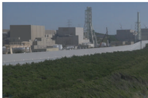
浜岡原子力発電所
