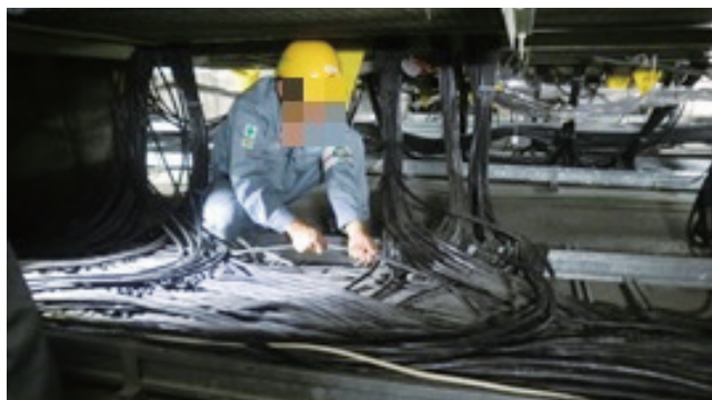
第1図 制御ケーブル撤去作業
