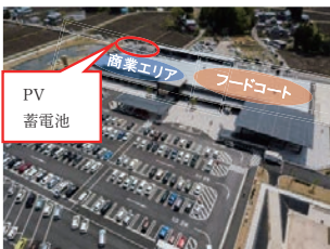
第2図 道の駅上空写真
