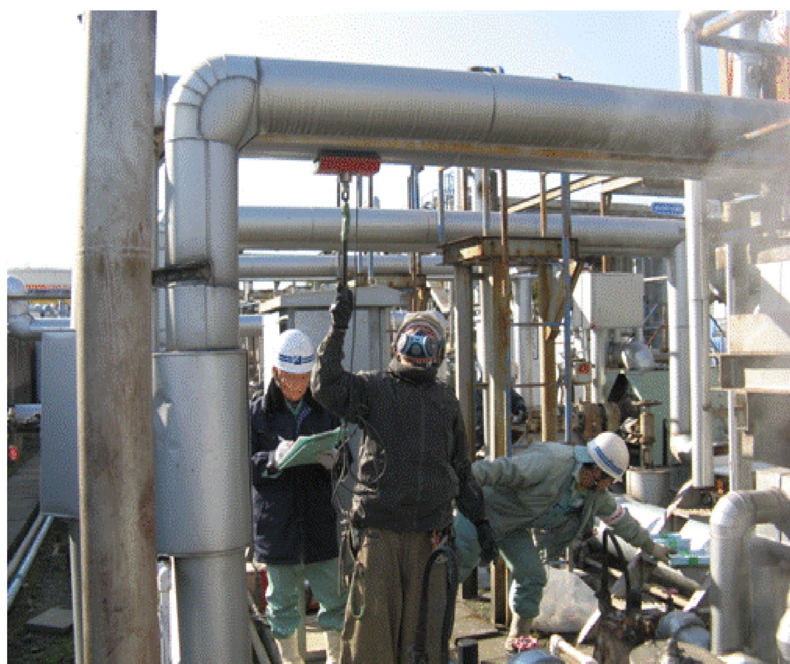
配管腐食診断の様子
