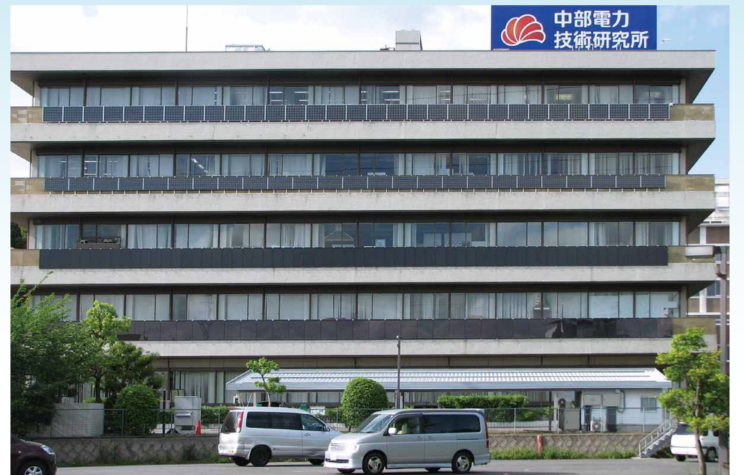
技術開発本部 西館 壁面
