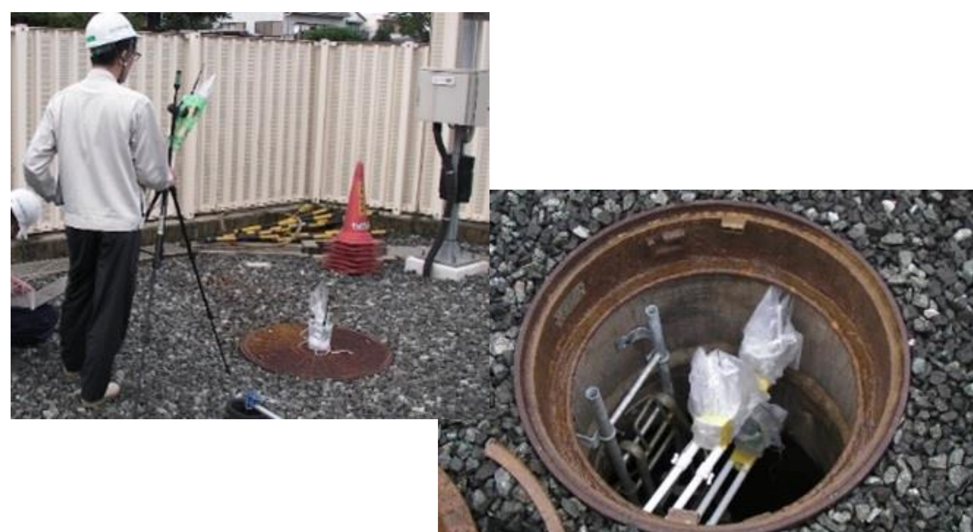
マンホール 通信実験
