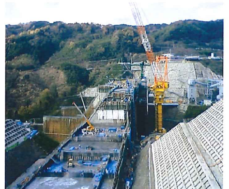
[石炭灰販売] フライアッシュセメントを使ったダム工事
