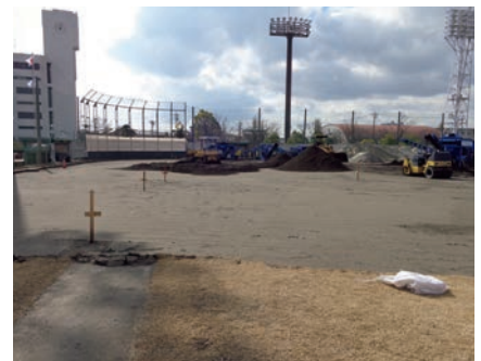
ランドプラスを使用した野球場の施工状況
