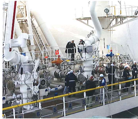
[燃料・海事事業] LNG荷役業務
