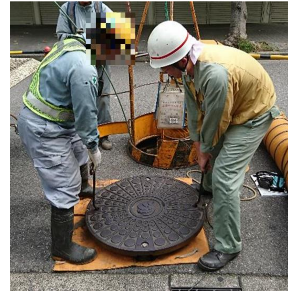
マンホール金蓋開閉作業
