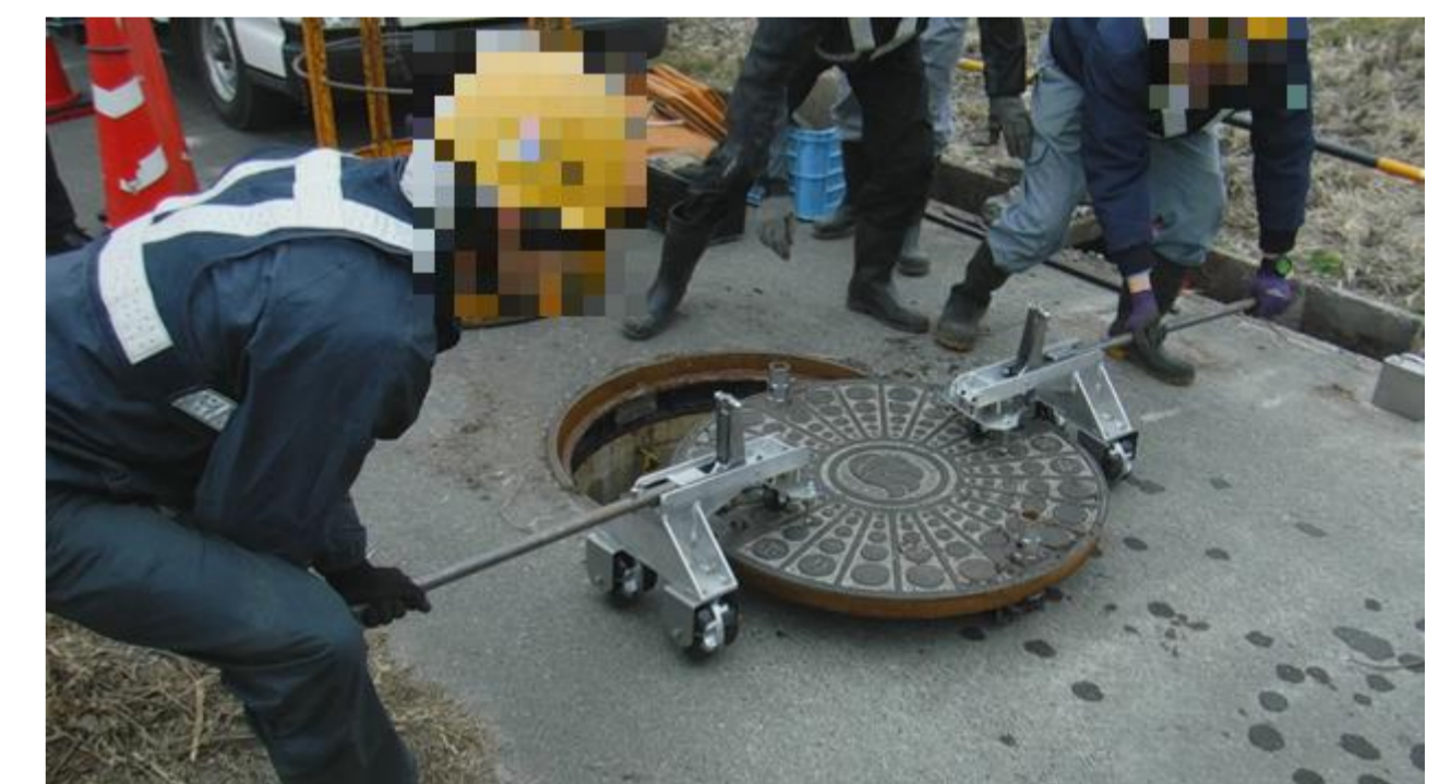
③マンホール「開」, 横へ移動
