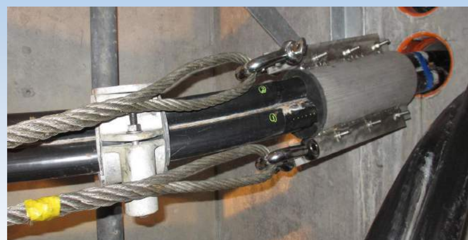
CVTケーブル引戻し装置使用状況
