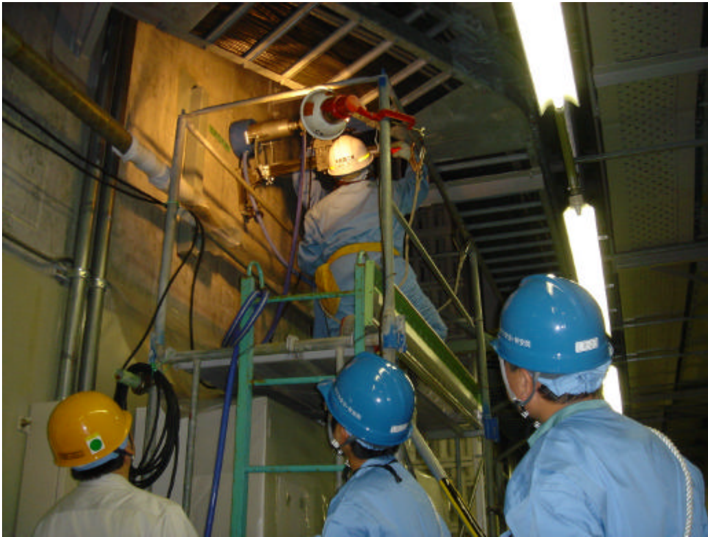
コアサンプル採取状況 (4号機タービン建屋2階)
